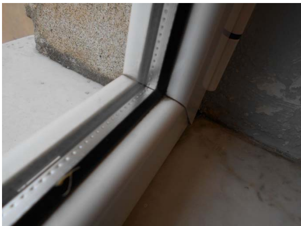
Figura 4.5 - Particolare dei serramenti in metallo e vetro doppio – dettaglio angolo vetro
