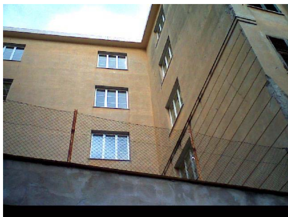
Figura 4.7 – Rilievo termografico dei serramenti
