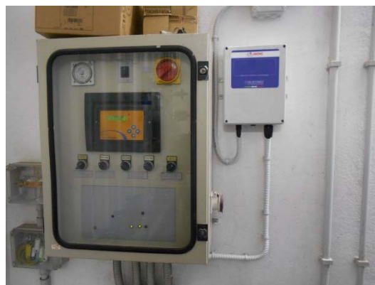
Figura 4.9 – Particolare della centralina di controllo dell'edificio e del dispositivo per la telegestione
