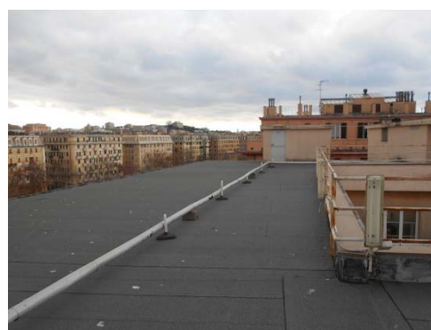
Figura 8.3 - Particolare della copertura
