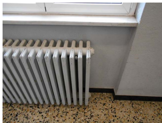
Figura 4.8 - Particolare di un radiatore in ghisa
