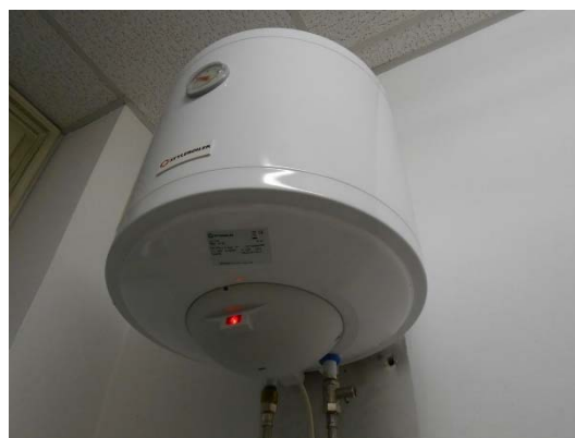
Figura 4.13 - Particolare di un boiler elettrico per la produzione di acqua calda sanitaria
