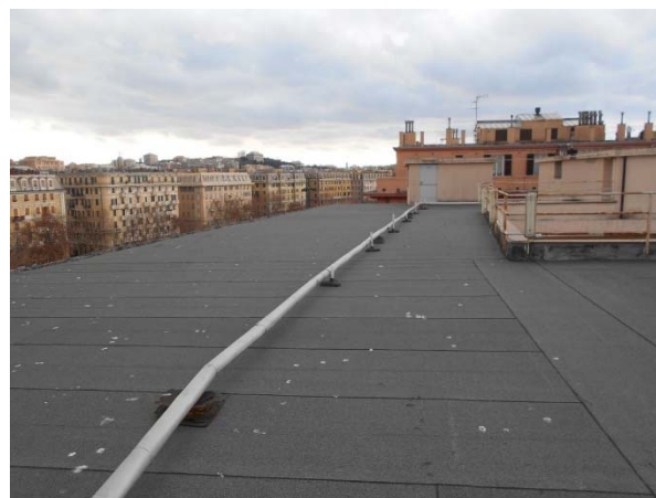
Figura 8.12 - Particolare della copertura dove installare l'impianto
